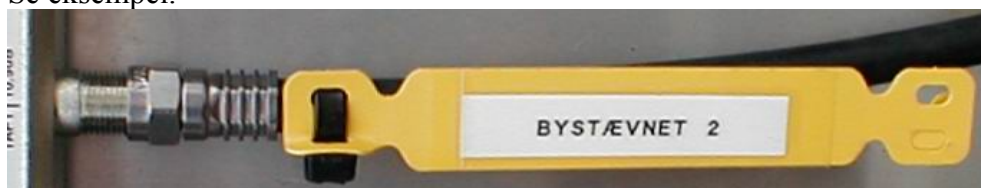
Figur 46: Eksempel på stikledningsmærkning
